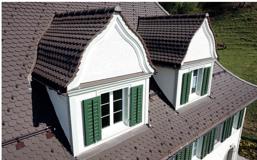
Mehrfamilienhäuser Cilander, Herisau Teils konvex- und konkavgeformte Casta Biberziegel Handgeformte Spezial-Walmkappen
