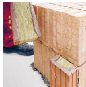
2. Einfach und sicher: Anschlagschale wird nachträglich mit Dünnbettmörtel seitlich an die Leibung geklebt
