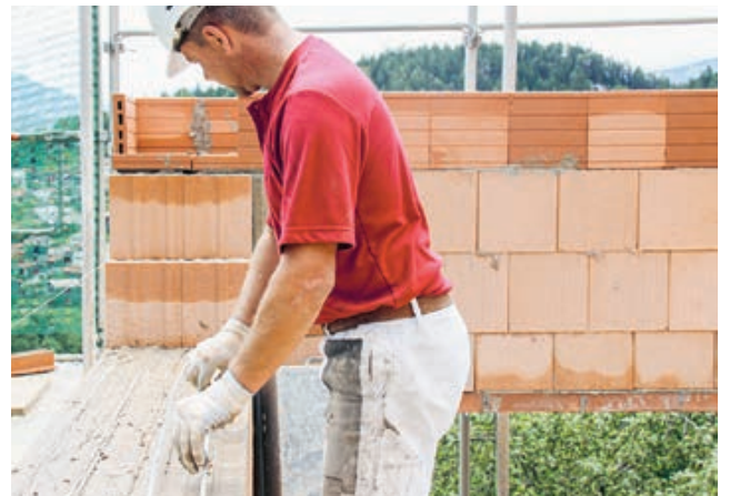
4. Lagerfugenbewehrung in Dünnbettmörtel verlegen
