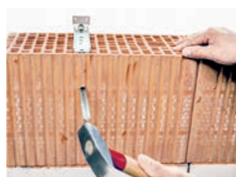
Lochschiene einschlagen
