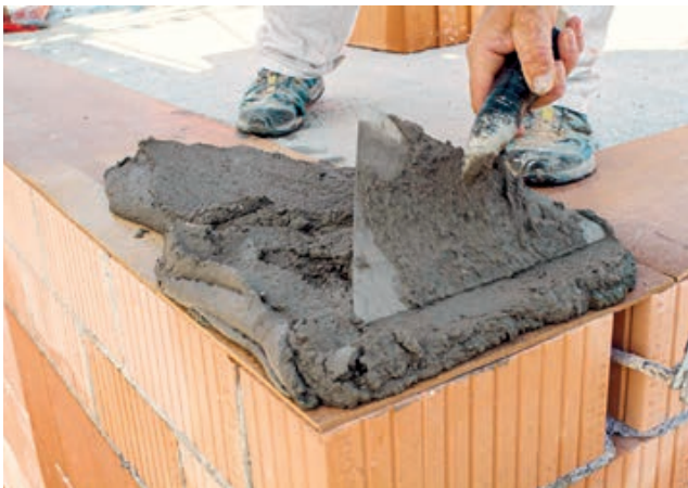
3. Ansetzmörtel zum Ausgleich auftragen
