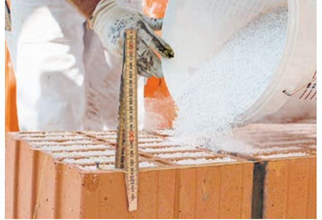
14. Lücke von oben grosszügig mit Perlit auffüllen
