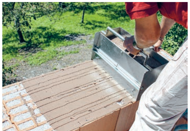
6. Schlitten gleichmässig ziehen und Mörtel auftragen
