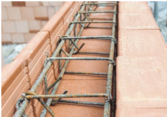
7. Bewehrungskorb in U-/WU-Schale einlegen
