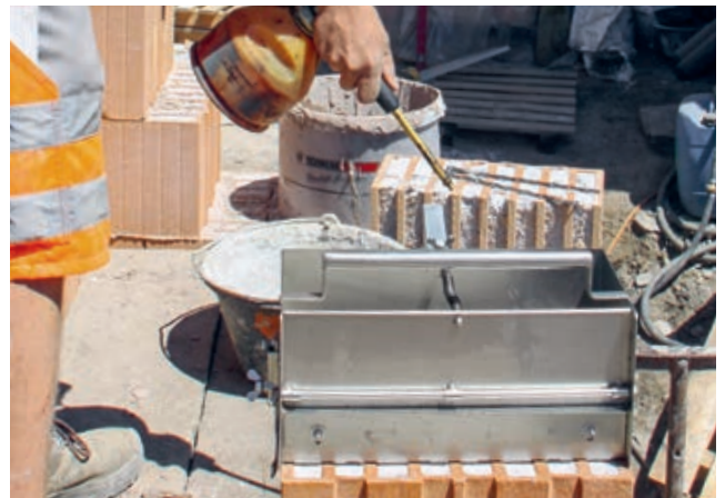
4. Mörtelschlitten mit Schalöl vorbereiten
