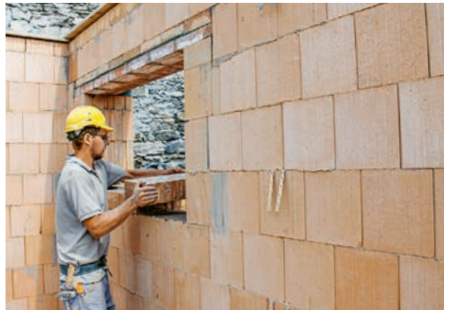
4. Brüstung zwischen den Leibungen ab letzter Normalschicht ausgleichen
