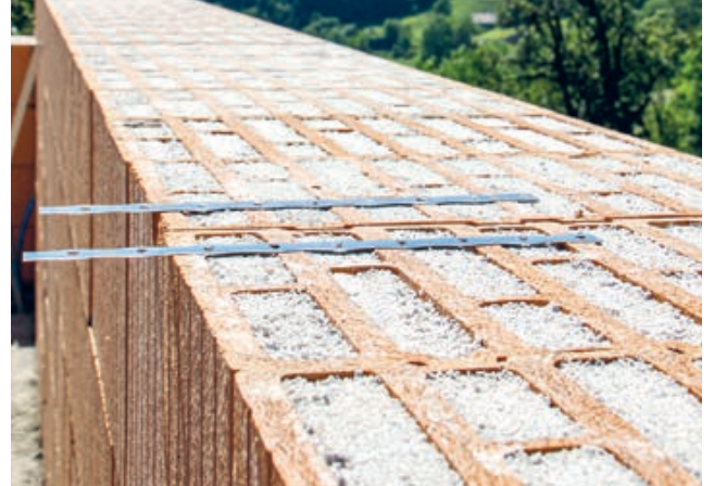
2. Mauerverbinder positionieren
