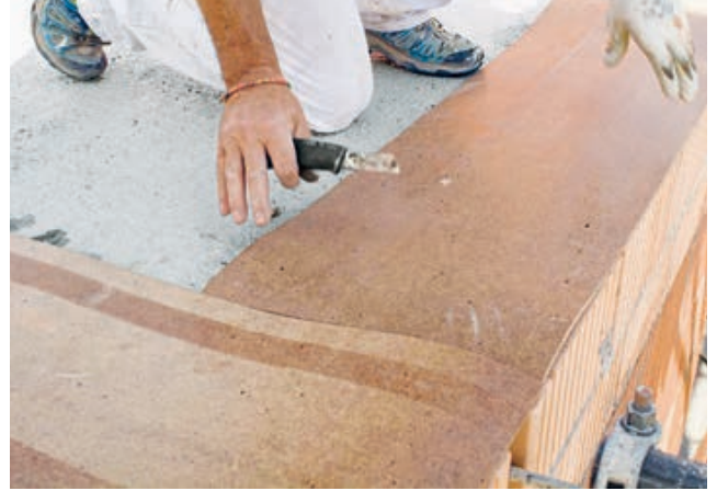
2. Trennschicht bzw. Lager ausrollen
