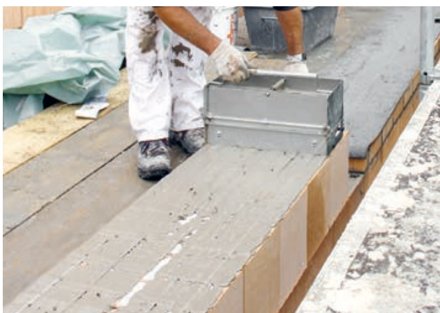
5. Vor dem Weitermauern nochmals mit Mörtel überdecken
