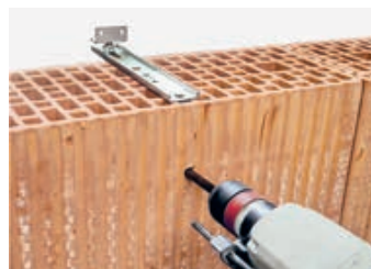
Loch vorbohren ca. 8 cm unter Kante
