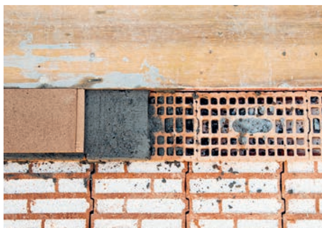
2. Auf dem Mörtelbett liegen die Deformationslager
