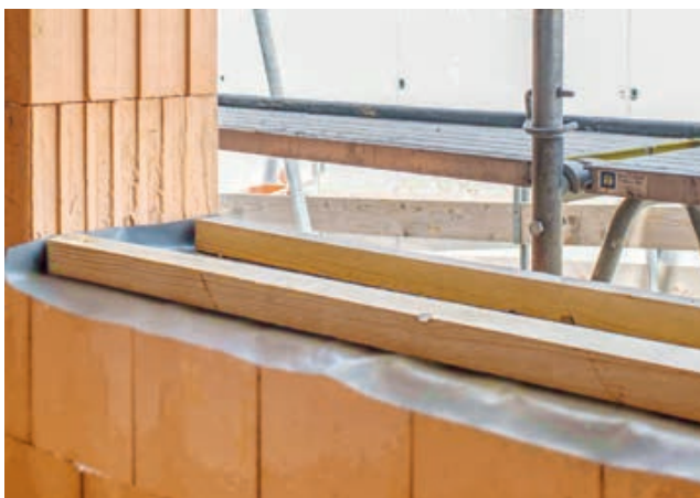
5. Brüstung während der Bauphase vor Witterung schützen
