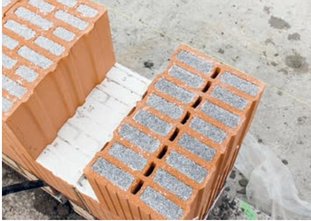
1. An Fenster- und Türleibungen Halbsteine setzen
