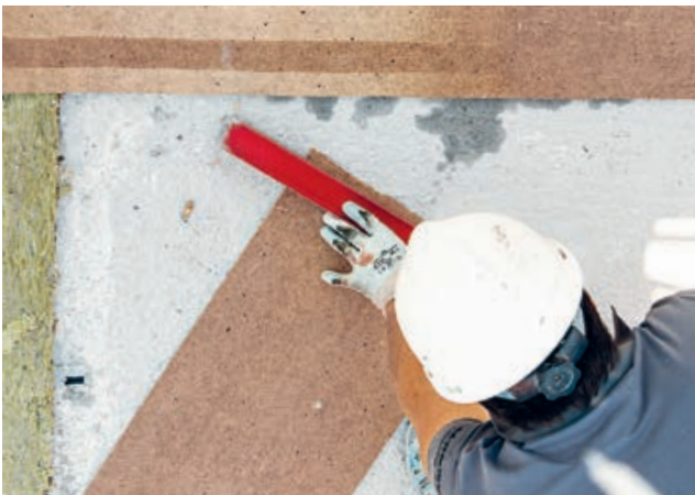
3. Porotherm-Pronouvo-Wandlager zuschneiden
