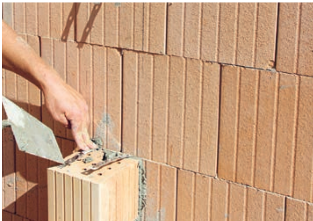
3. Innenwand hochziehen und einbinden
