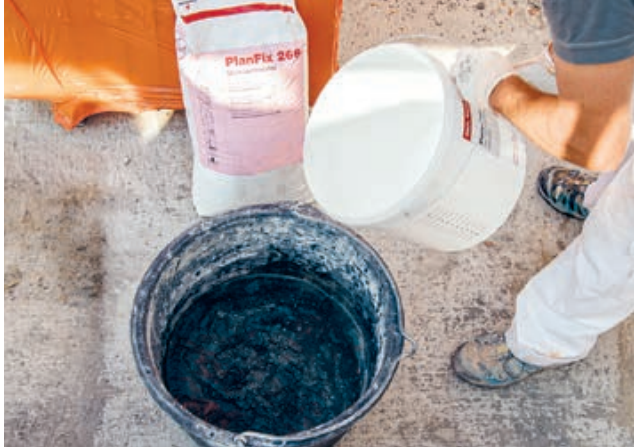
1. Wasser für Mörtelmischung genau abmessen
