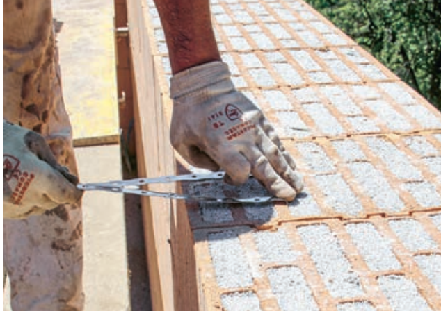
1. Mauerkrone mit Feile ca. 0,5 mm ausnehmen
