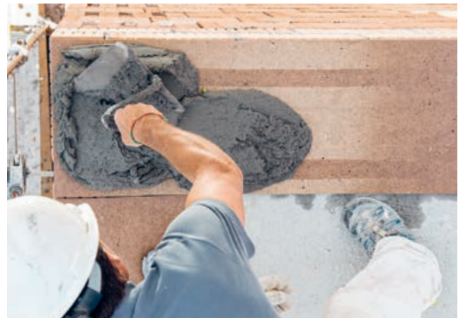
4. Ansetzschicht aufbringen
