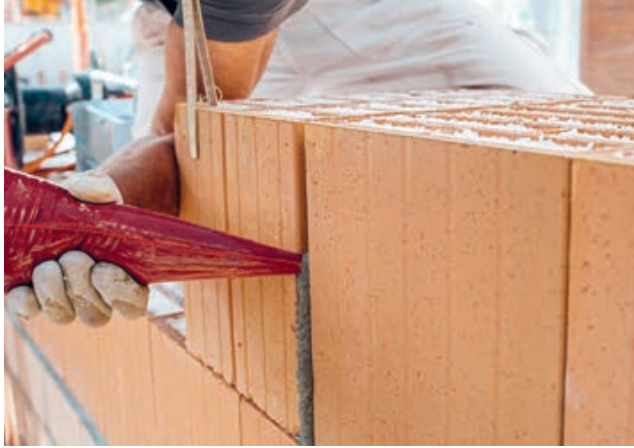
13. Kleine Lücken über 5 mm \leq 15 mm aussen mit Leichtmörtel füllen
