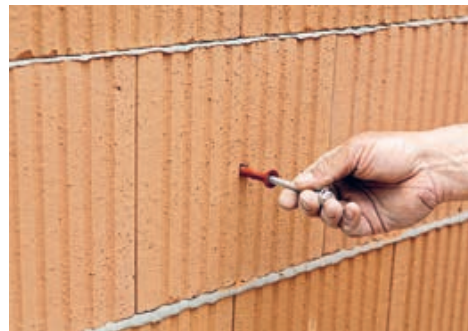
2. Dübel (ggf. mit Schraube) ansetzen
