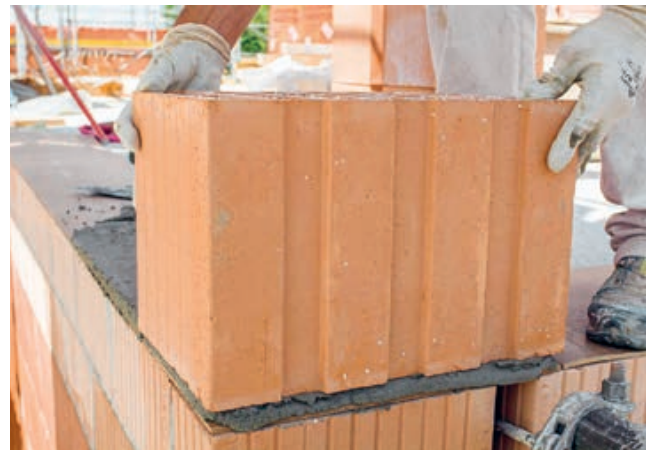
4. Den ersten Stein in der Ecke setzen
