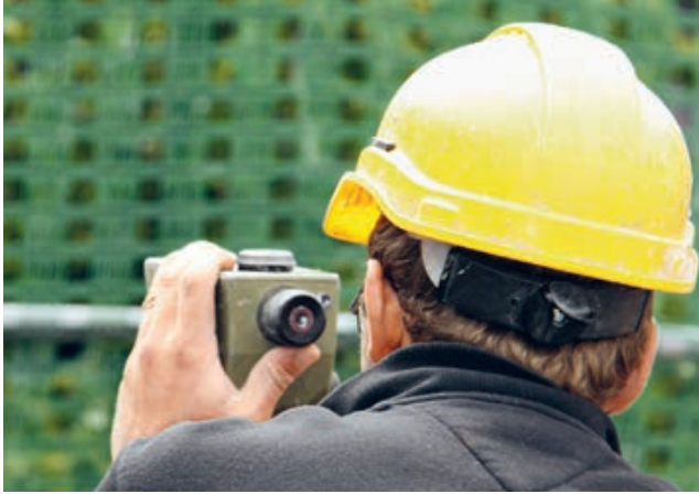
1. Höchsten Punkt der Decke eruieren
