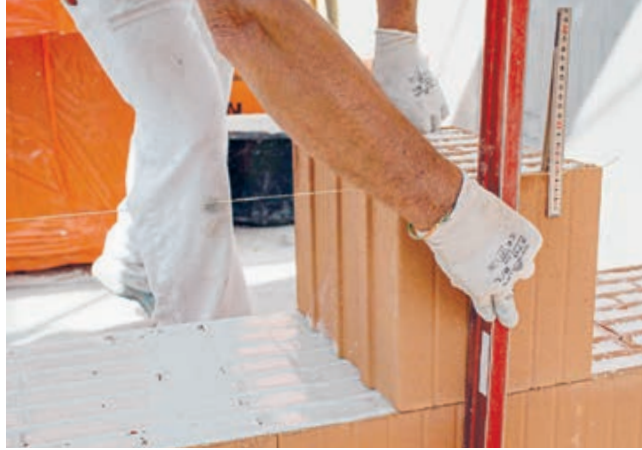
8. Richtschnur ziehen und Ausrichtung prüfen
