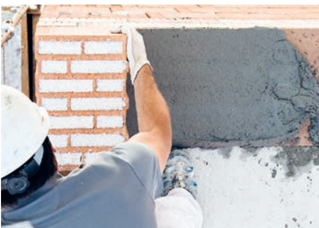
5. Neue Geschosswand hochziehen
