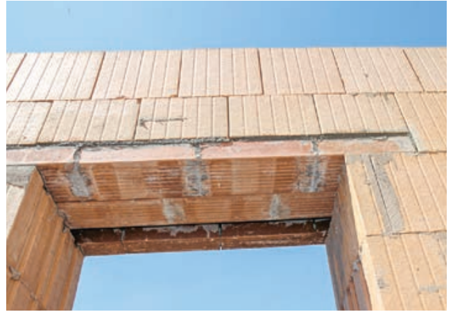
2. Stossfugen bei Sturzübermauerung mit Dünnbettmörtel füllen (tauchen)
