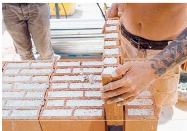
12. Passtücke einfügen
