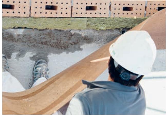
2. Für neue Geschosswand Trennlage ausrollen z.B. Porotherm-Pronouvo-Wandlager
