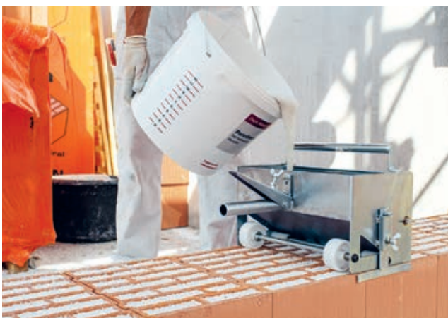
5. Mörtelschlitten füllen
