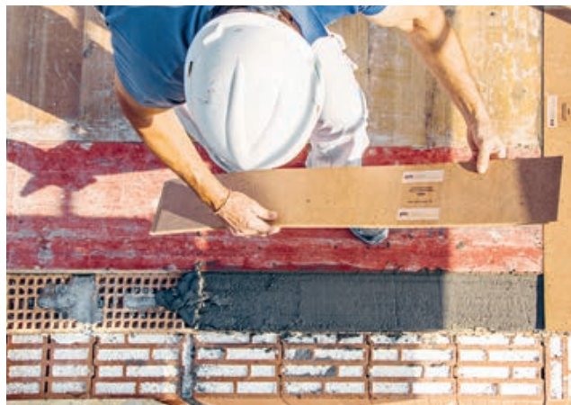
1. Exzentrisches Deformationslager mit einseitig weichem Randstreifen und Tragkern wird angepasst
