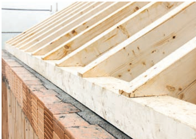
8. Ausbetonieren und z.B. Fusspfette befestigen
