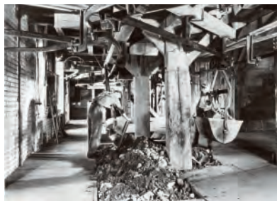
Die Rohmaterialmischung gelangte per Seilbahn in das Dachziegelwerk an der Birs – Aufnahme von 1950
